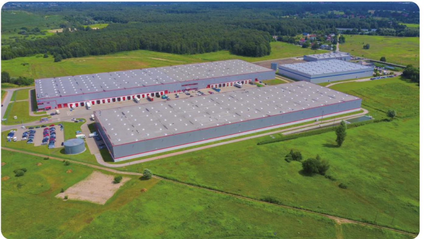
图2-无人机建筑测量
