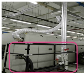
回流炉接入中央空调冷冻水
